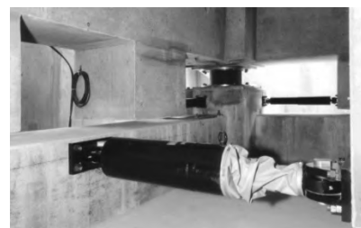
(ت) میراگر ویسکوز
