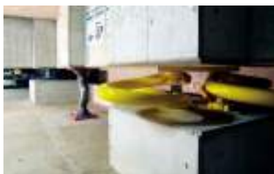
(ج) میراگر تسلیمی سربی و تسلیمی فولادی
