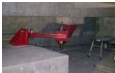
(پ) میراگر اصطکاکی
