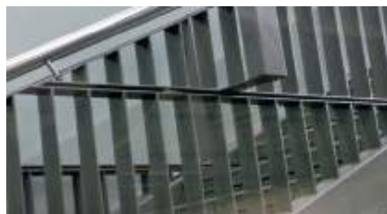
تیر بغل و نرده‌های راه پله بریده شده تا حرکت در تمامی جهات افقی، امکان پذیر شود
