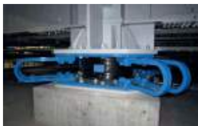
(ب) میراگر تسلیمی فولادی U-شکل
