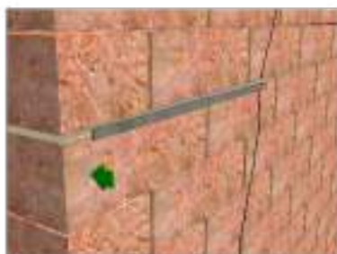
ث) نصب میله درون شیار
