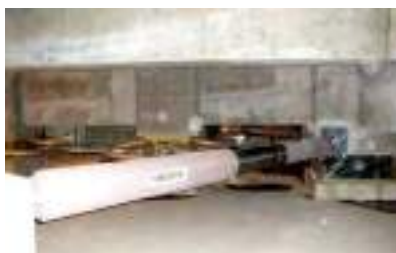
(ث) میراگر ویسکوز و تسلیمی فولادی
