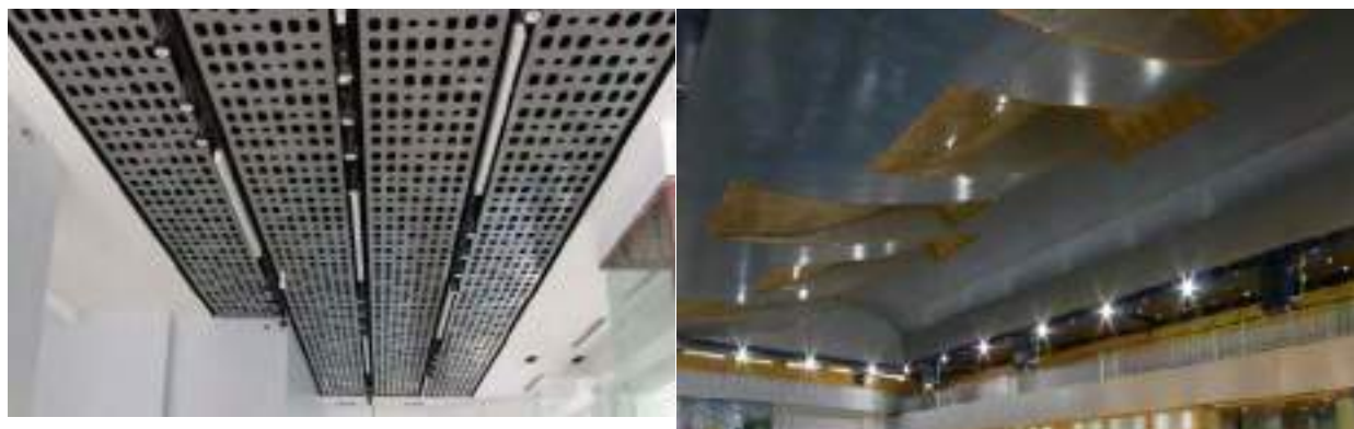
ب- ورق سورخدار توسط دستگاه پانچ یا CNC
