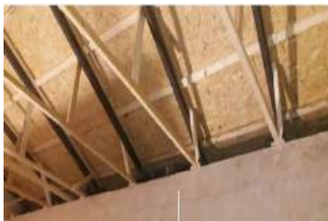
شکل ۸-۷۰- زیرسازی با چهارتراش‌های چوبی به فواصل حداکثر ۶۰۰ میلی‌متر که توسط پیچ به پروفیل‌های فولادی سقف سازه متصل شده است
