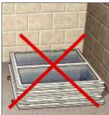
شکل ۱۲-۶۴- روش‌های درست و نادرست انبار کردن پنجره‌ها و درها
