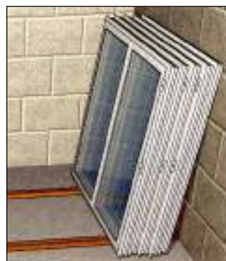
شکل ۱۲-۶۴- روش‌های درست و نادرست انبار کردن پنجره‌ها و درها
