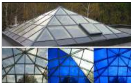
شکل ۱۲-۷۴- نمونه پوشش سقفی شفاف تغییر رنگ دهنده با شیشه‌های الکتروکرومیک
