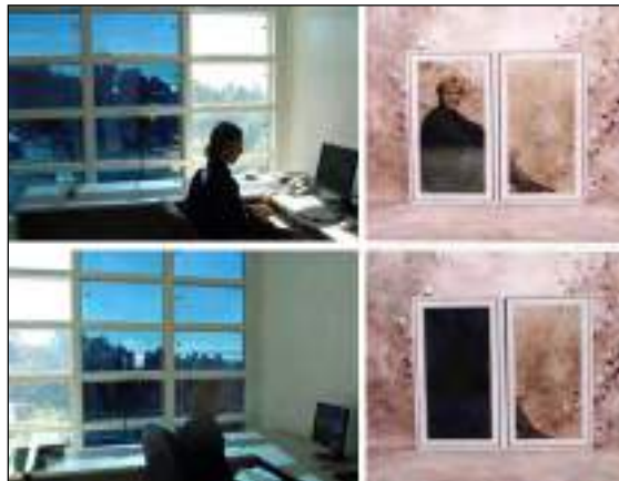
شکل ۱۲-۷۵- نمونه عملکرد پنجره‌های با شیشه‌های الکتروکرومیک
