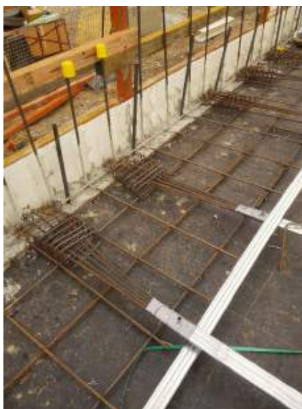
ت) سر مرده تاندون‌ها در سیستم به هم چسبیده
