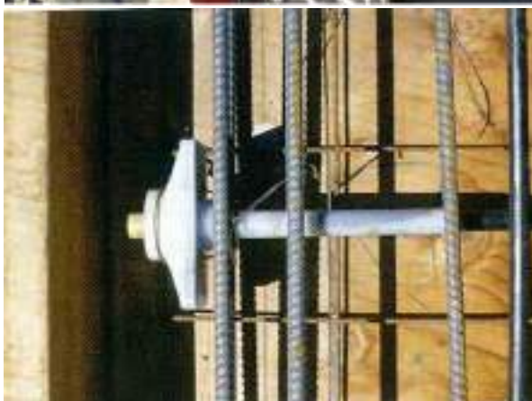
ث) سر مرده تاندون‌ها در سیستم‌های بهم چسبیده
