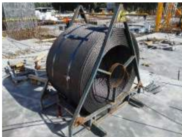
پ) قرقره تاندون‌ها و باز کردن تاندون‌ها و جایگذاری آن‌ها توسط ابزار هدایت از روی قرقره (انتهای مرده تاندون در فاصله ۵۰ میلی‌متری قالب جداره قرار می‌گیرد)
